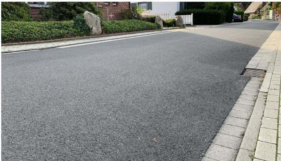
Die Vorgabe des Bauprogramms ist im Bereich vor den Grundstücken Nr. 8 und 21 im Hinblick auf die Herstellung einer 2-reihigen Entwässerungsrinne nicht umgesetzt worden, da in diesem Bereich lediglich eine 1-reihige Entwässerungsrinne angelegt wurde. Hinsichtlich der abweichenden Bauausführung ist in der Sitzung des Umwelt- und Planungsausschusses vom 24.09.2019 ein Abweichungsbeschluss gefasst worden, mit dem der abweichenden Ausführung bezüglich der Entwässerungsrinne zugestimmt worden ist.
