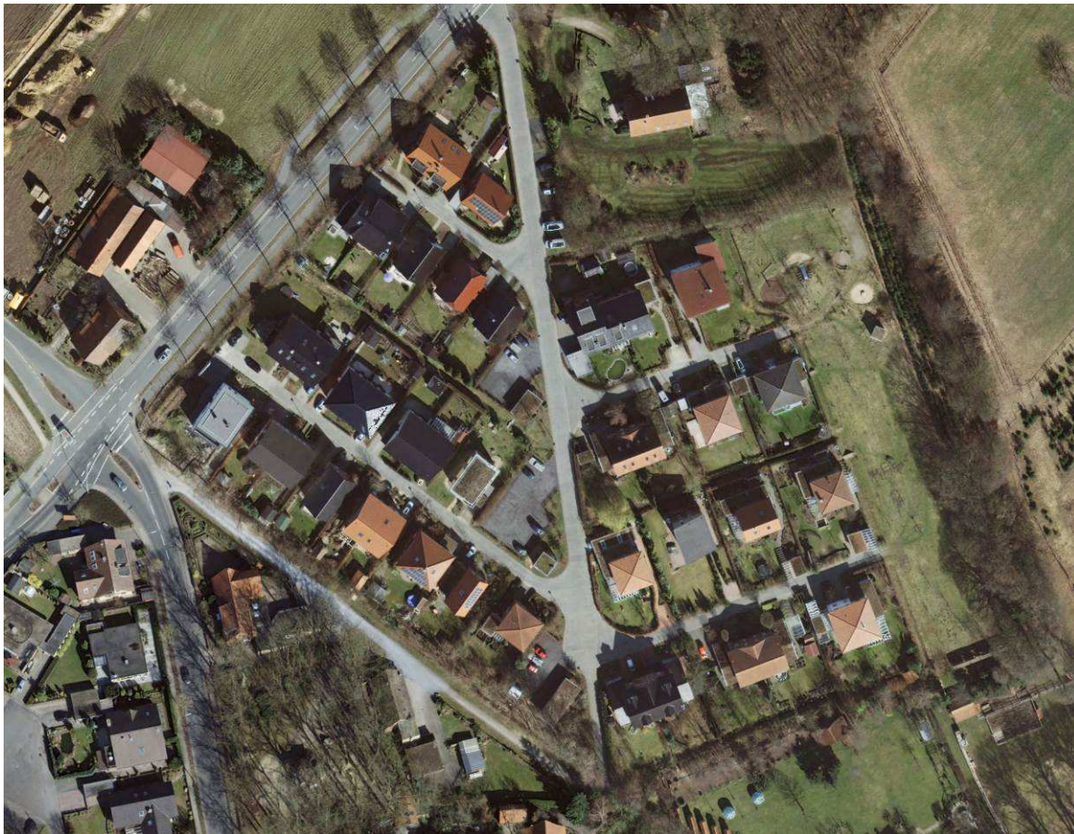
Abb. 2: Luftbild der Wohnsiedlung Berkenkamp
