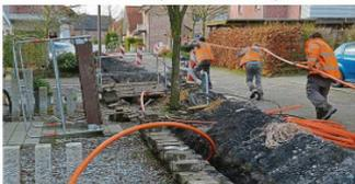
So sieht Biber im Straßen und es folgt auch in Ostbevern ausfallen. Die Bauarbeiten beginnen mit dem Ausbau des Glasfasernetzes, sobald die Grabenlöcher fertig sind.
