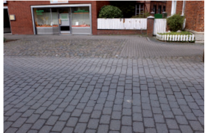
Schäden in der Fahrbahn
