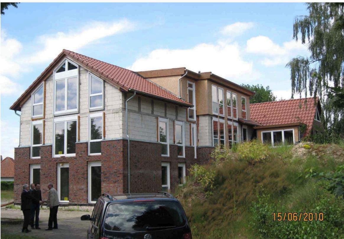
10. Nordöstliche Fassade des Vorhabens. Dachaufbauten werden zu Gauben (in Flucht der zurück gesetzten Fassade) zurückgebaut, Dach wird davor durchgeführt, Höhe der Gaube wird reduziert. Fenster erhalten geschlossen Brüstung hinter der schrägen Dachfläche / DrempeI.
