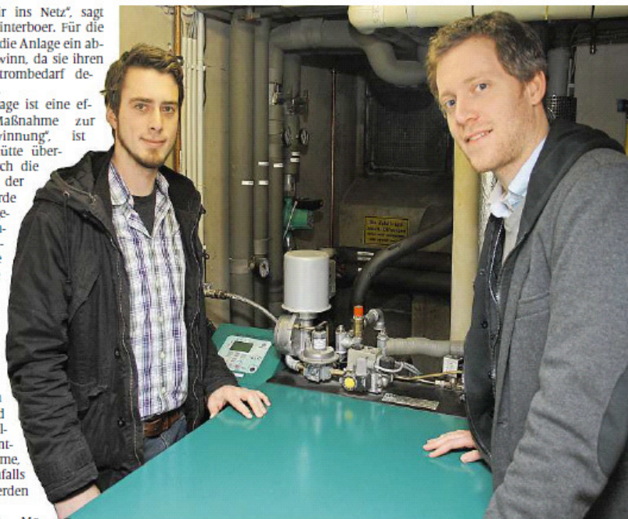
Julian Schütte und Constantin Krass (l.) informieren über die Ausstattung von Gebäuden mit Mini-Blockheizkraftwerken.
