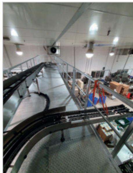
Neue Verbindungsstraße zu den 4 Linien der bestehenden Hallen 2 + 3
