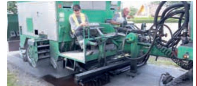
Sanierungsarbeiten auf den Wirtschaftswegen in Ostbevern. Dafür werden in diesem Jahr ca. 100 t Bitumen und 800 t Splitt verbraucht. Der Bauhof wird zum Abschluss der Arbeiten 65.000 m<sup>2</sup> Fläche ausgebessert haben.
