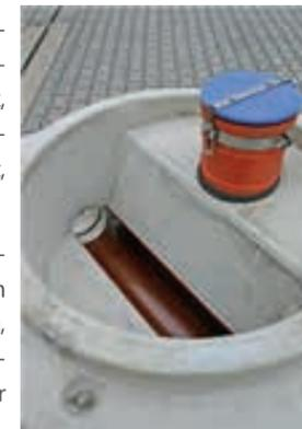
Infolgedessen wird der Abwasserbetrieb nun auch in weiteren Baugebieten die Kombinationsschächte prüfen und Verschlussdeckel, soweit nicht mehr vorhanden, ersetzen.
