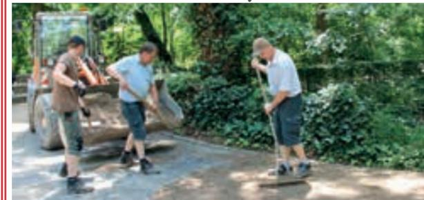
Überarbeitung von ca. 1.050m<sup>2</sup> Verkehrsfläche im Telgenbusch. Das heißt: Abtragen der alten Deckschicht, Herstellen eines Schotterplanums und Auftragen der wassergebundenen Decke mit 15 t Dolomitsand.
