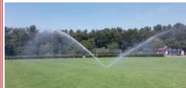
Einbau einer neuen Tiefenpumpe im BEVERSTADION. Jetzt beregnen die Mittelkreisregner wieder in gewohnter Weise und zwar mit einem Radius von 30m. Die Seitenregner erreichen eine Wurfweite von 25m. Die neue Pumpe fördert das Wasser nun mit einem Druck von 10 bar. Der Bauhof bewässert die Plätze im Sommer zwei bis dreimal pro Woche.
