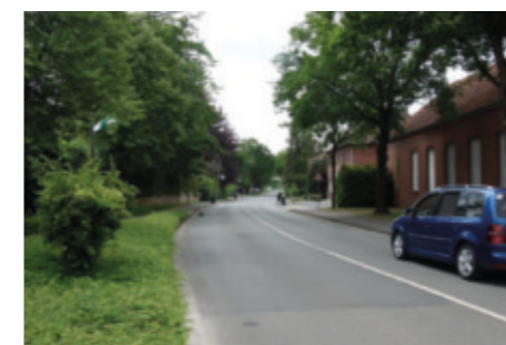
Abb. 19: Ortsausfahrt Ladbergener Straße 1
