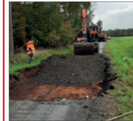
Erneuerung von Bankettstreifen im Außenbereich
