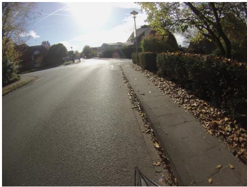
Engelstraße/ Liener Damm (Fahrbahn bei 50 km)
